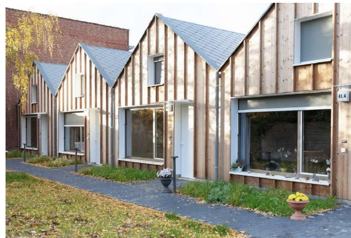
Schoolstraat Wijnegem - Osar architecten - © Osar Architects
